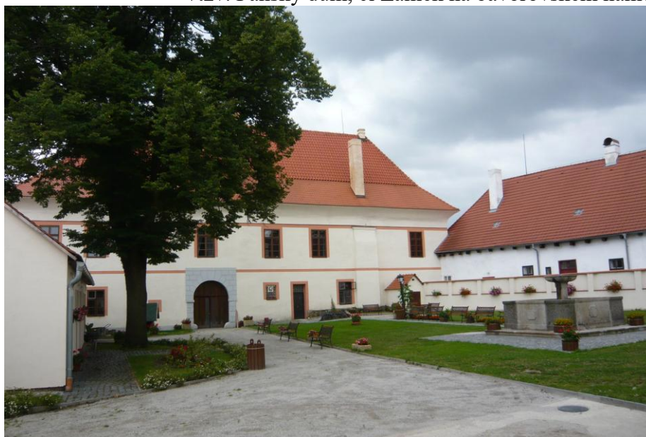
/zrekonstruované nádvoří zámku v Bavorově s hospodářskými budovami/
