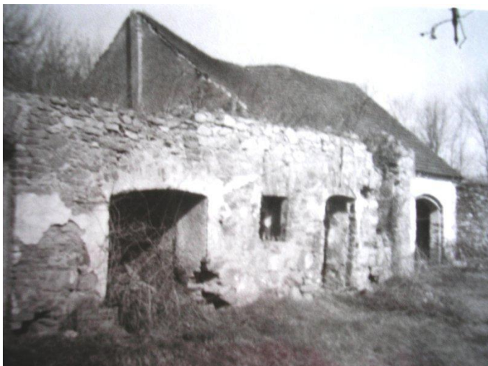
/devastované hospodářské budovy, kol. r. 1991/
