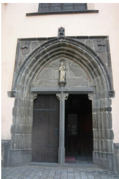
/gotický vstupní portál bavorovského kostela/
