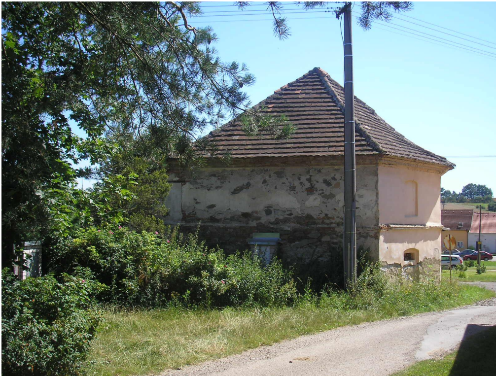
/pohled na obytné stavení č.p. 4 z cesty do Radán, r. 2009/
