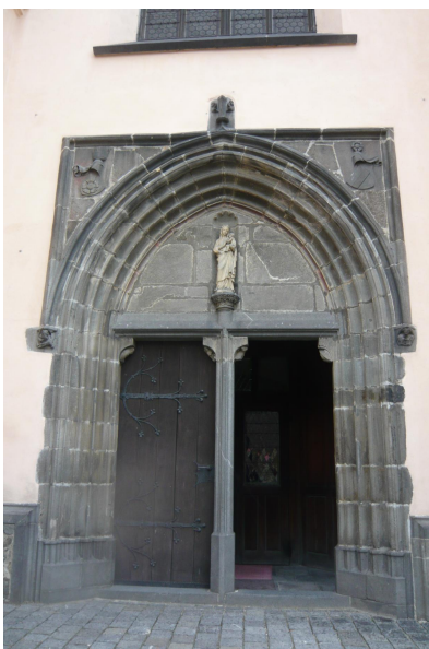
/gotický vstupní portál bavorovského kostela/
