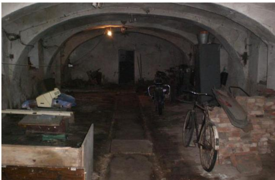
/pohled do interiéru maštálí s hodnotnou klenbou, postavených kol. r. 1820, stav 2010/
